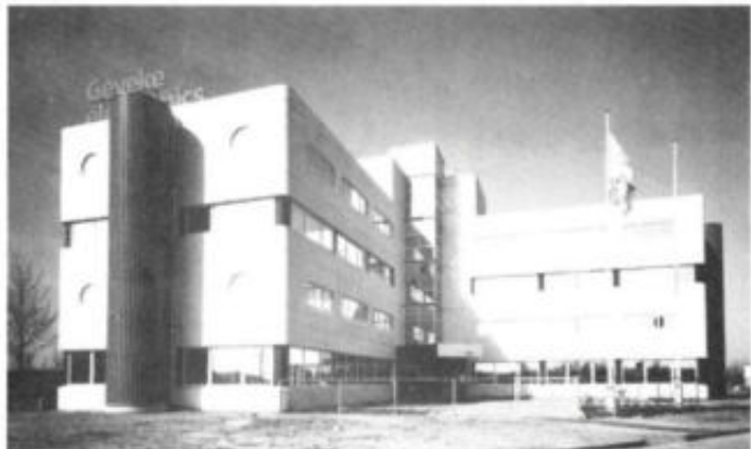
Het nieuwe kantoor- en bedrijfsgebouw van Geveke Electronics in Amsterdam-Sloterdijk.
