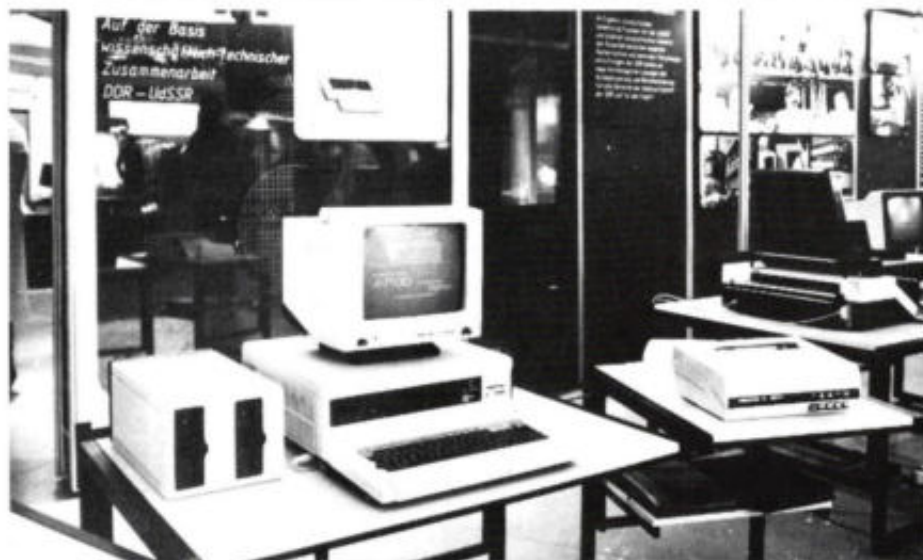
Afb. 17. Professionele 16-bit microcomputer uit Robotron's A7100-serie, bestemd voor administratieve en wetenschappelijke toepassingen en uitgerust met 64 Kbyte werkgeheugen.
